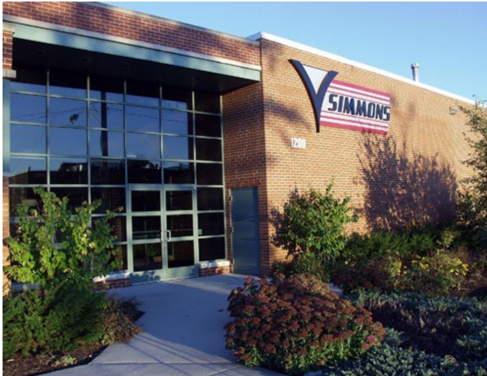
Planta de Fabricacion de Simmons Engineering Corp. Wheeling, IL USA
